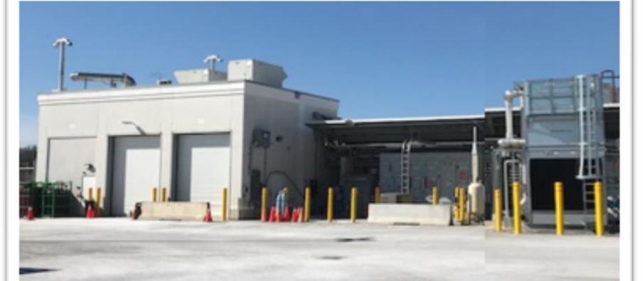
5MW Power-to-Gas, Ontario
