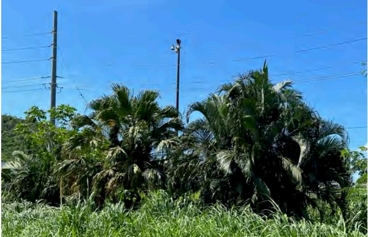
Foto #5 – Vista en acercamiento de palmas y árboles observados en el predio Caguas BESS.
