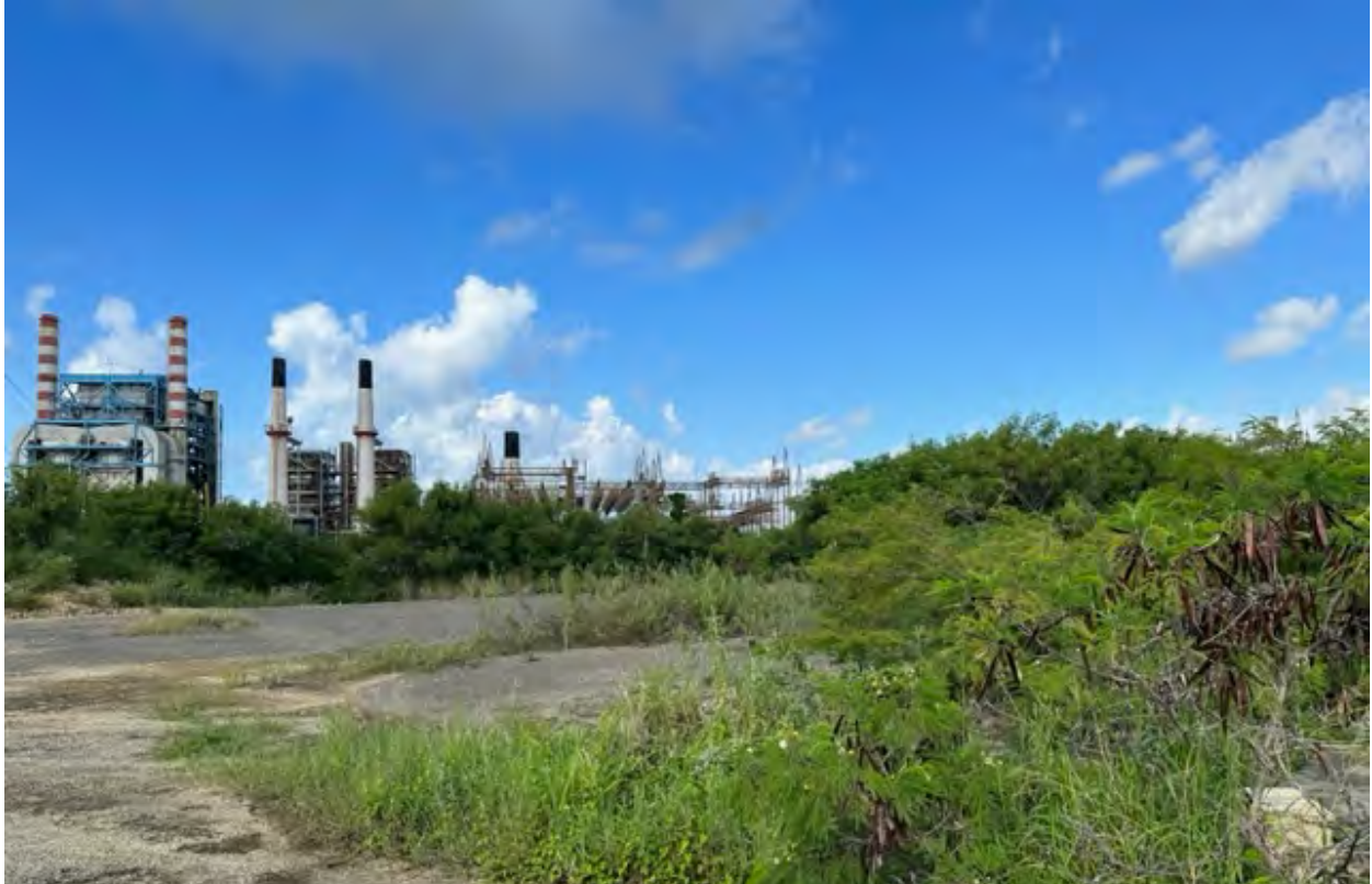
Foto #1 – Vista hacia el sur del predio propuesto para proyecto Peñuelas BESS.
