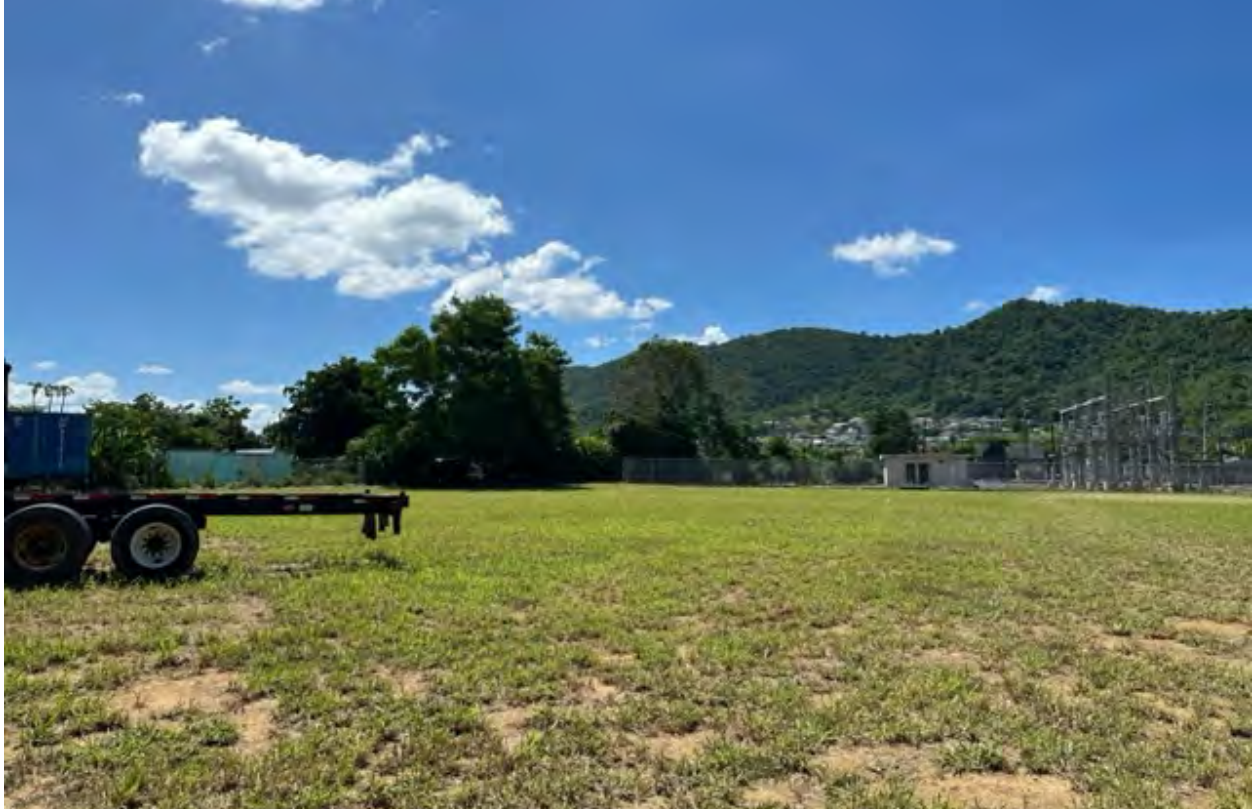
Foto #1 – Vista hacia el noroeste en el predio propuesto para proyecto Caguas BESS.
