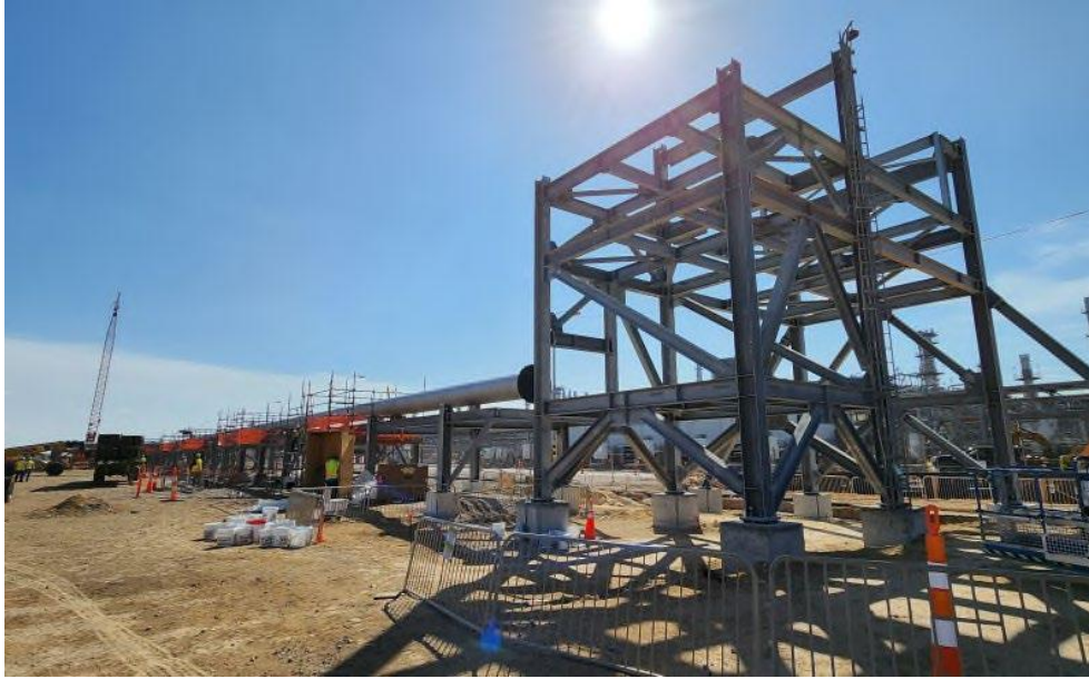
Photo 3: 310R19 LNG Transfer Rack Aboveground Pipe Installation
