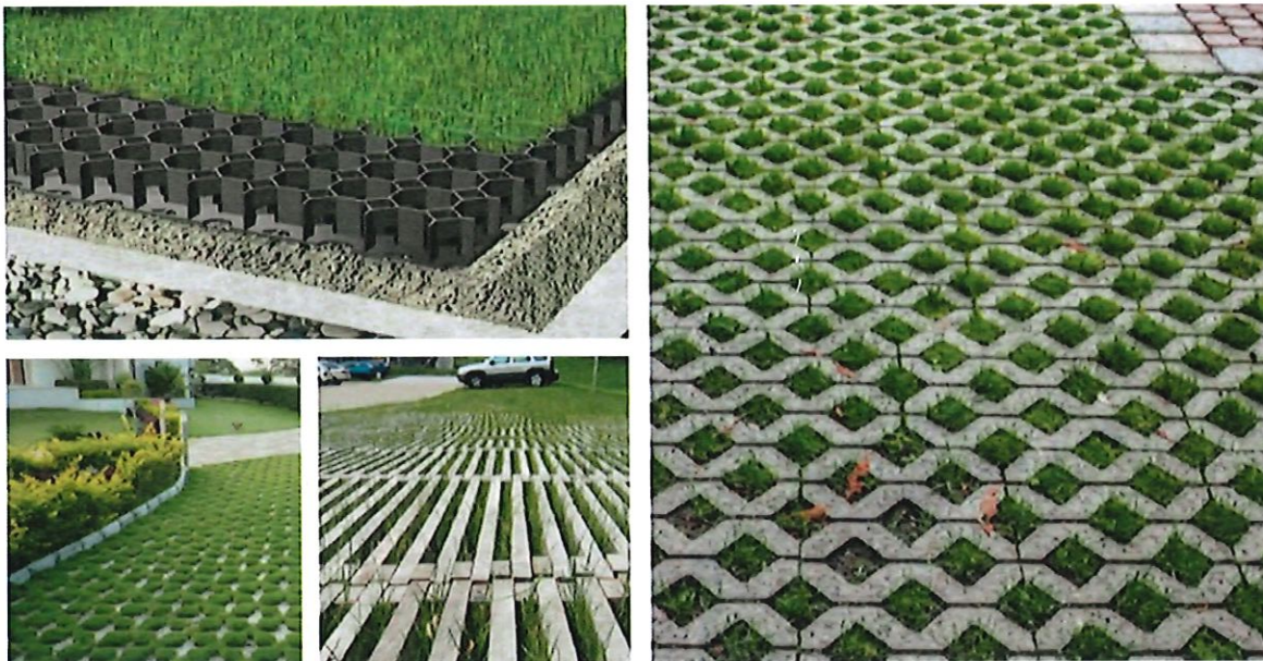
Figura 10.24 Pavimentación con césped o gravilla con refuerzo
