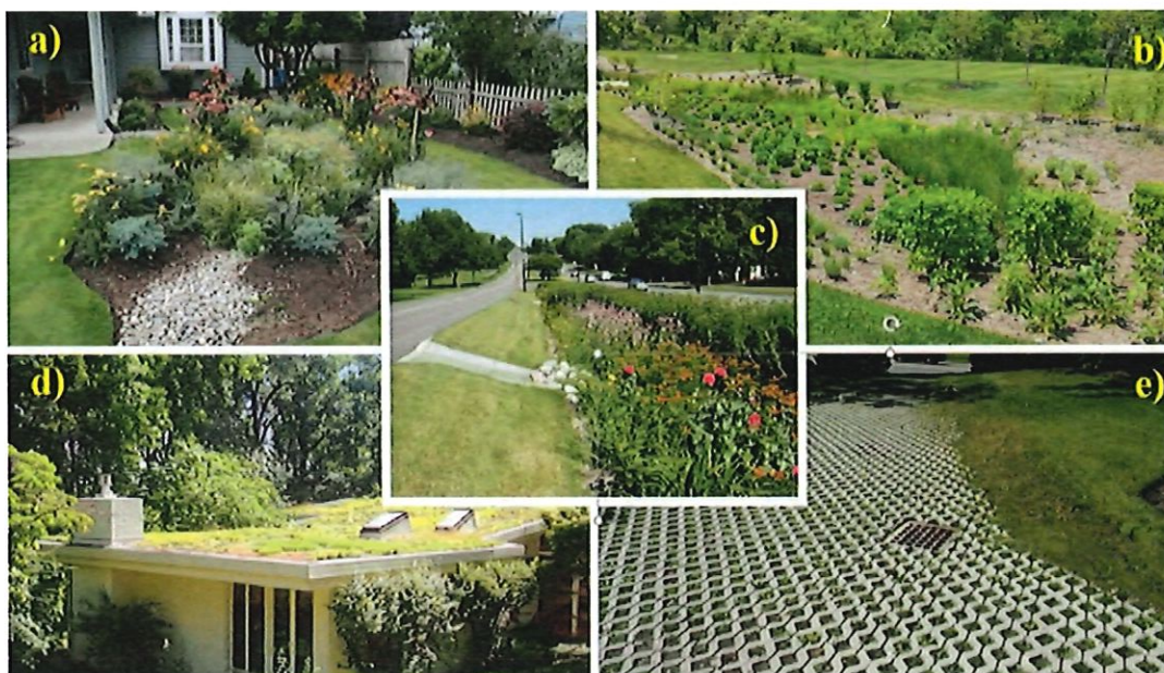
Figura 10.1 Prácticas de desarrollo de bajo impacto (LID): a) Jardín pluvial; b) Estanque de biorretención; c) Zanja vegetada; d) Techo verde; e) Pavimento permeable.
