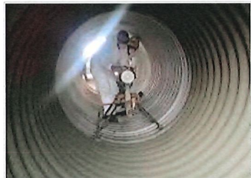
Figura 8.4. Revestimiento centrifugado de concreto para reparar tubos pluviales defectuosos. Se muestra el aplicador (spincaster).
