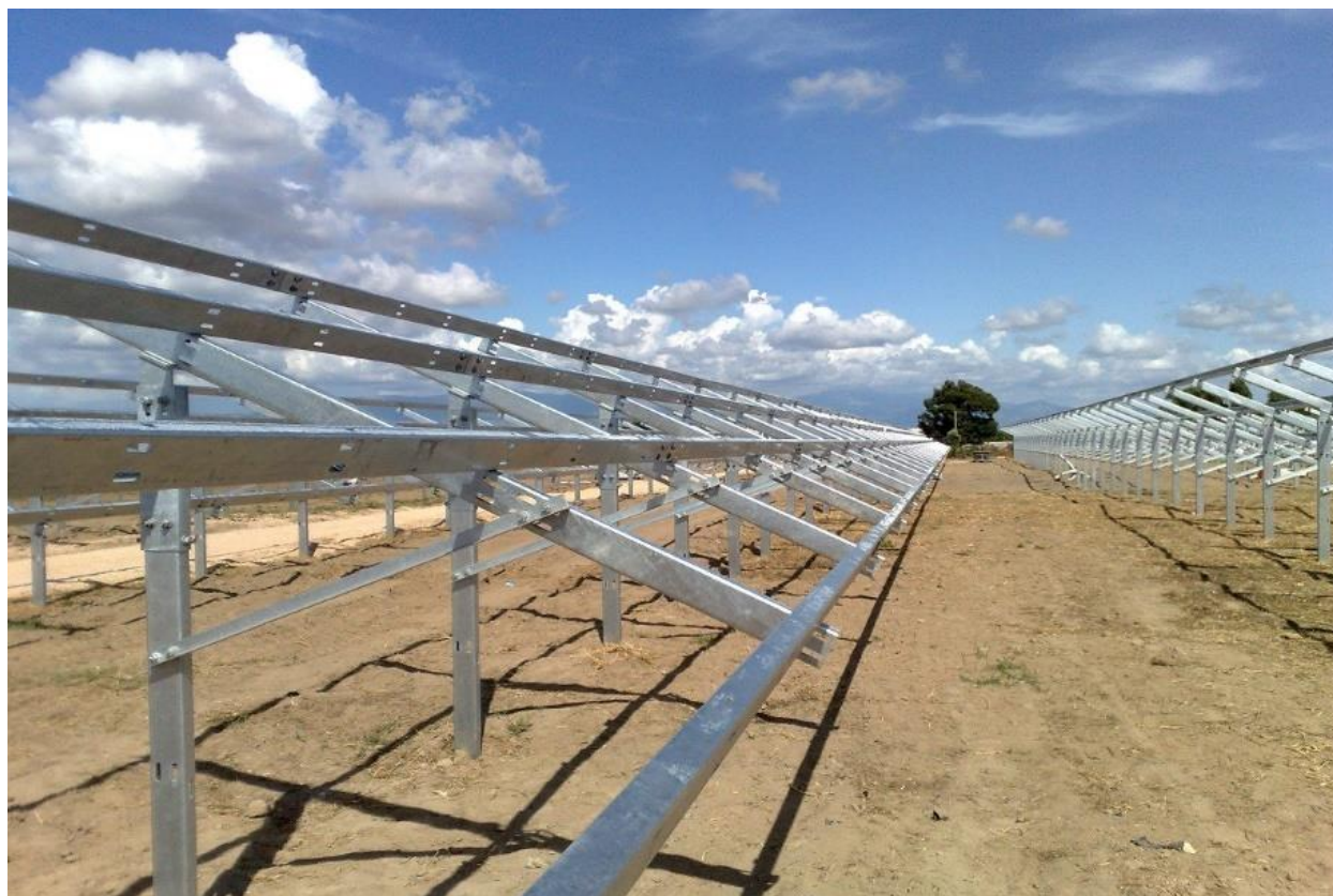
Figura 7. Estructura de base fija
