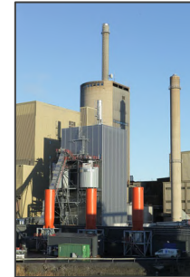
Vaskiluoto 140 MW CFB biomass gasifier (valmet.com)
