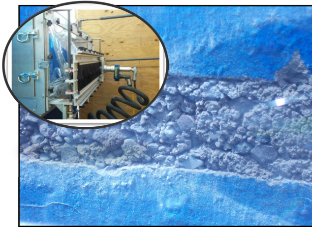
Wall scabbling using Nitrocision®
