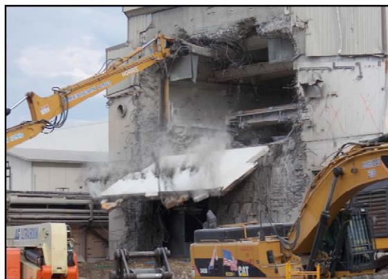
Removal of upper VF shield door
