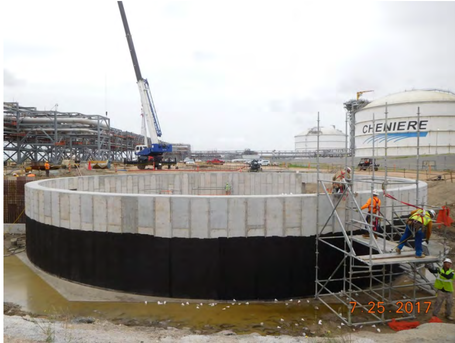
Stage 3 OSBL – LNG Sump
