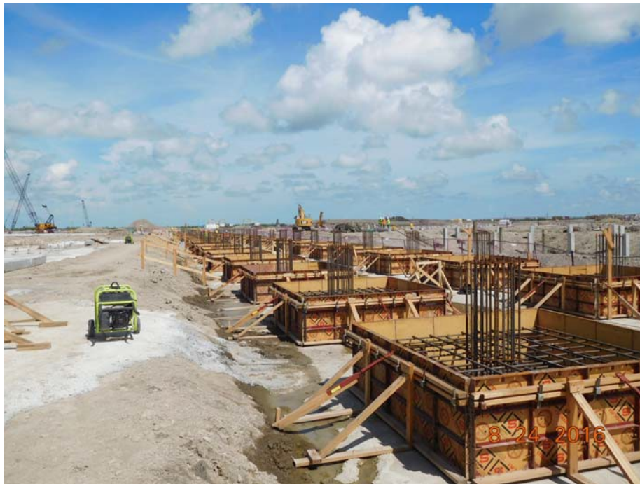
Stage 3 OSBL - Pipe Rack R07 Foundations, Ready to Pour
