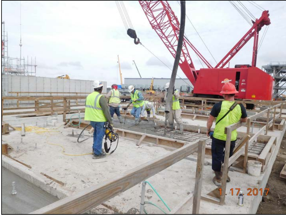
Train 5 – Pouring C01 Area Pads
