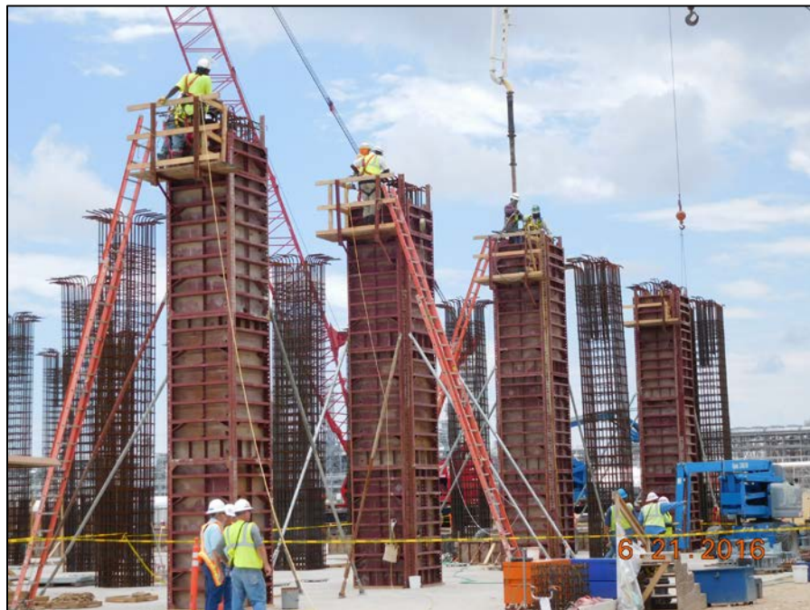
Train 5 - Compressor Area, Propane Columns First Concrete Pour
