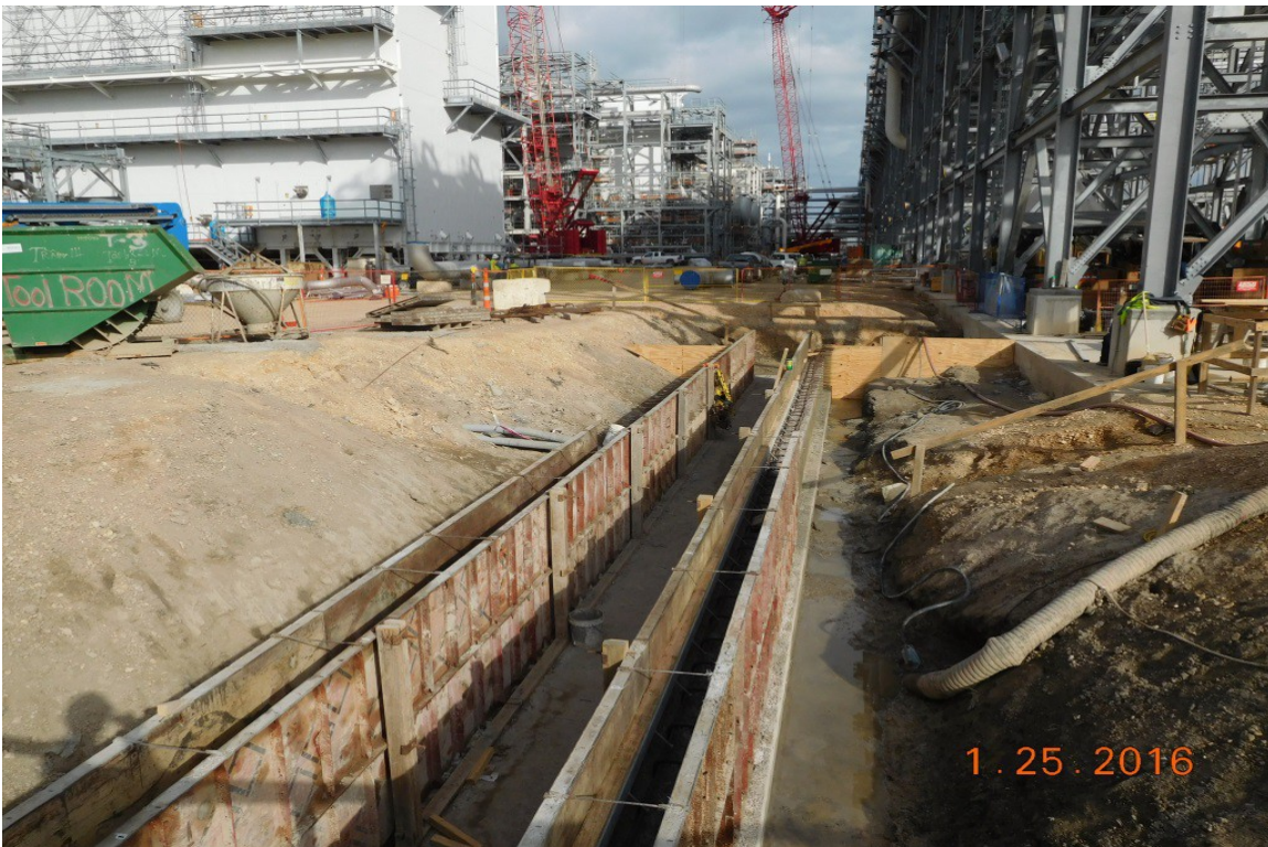
Train 3 – LNG Trench Installation
