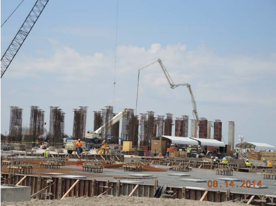
Train 4 Pouring Columns
