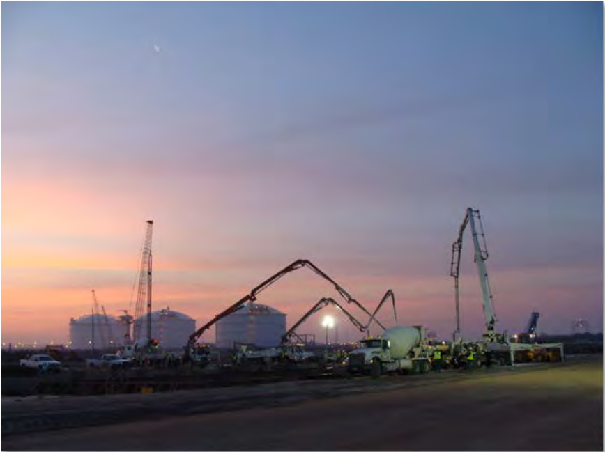
Concrete Pour, Area 132N (8-Mar-2013)
