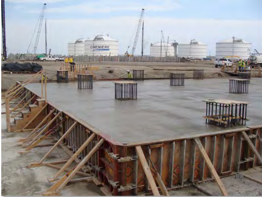
Finished Concrete Mat Pour (8-Mar-2013)
