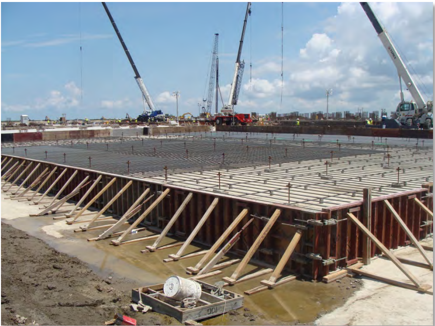
Area 131J Rebar (30-Apr-2013)
