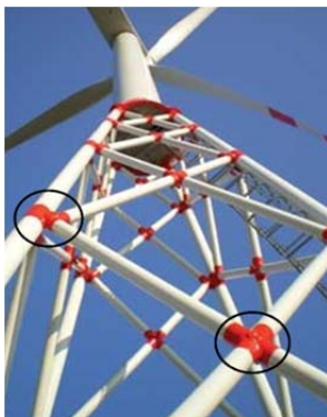
Fig. 2.5.2 Weserwind cast steel nodes
